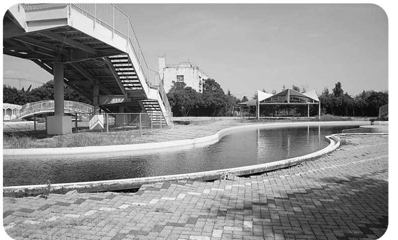
震災の被害を受けた市民プール
