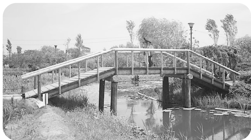
木橋の架け替え工事が終了した水郷佐原水生植物園
