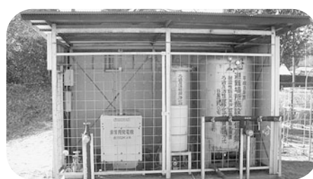
山田地区に設置されている防災井戸(写真は山倉小学校)
