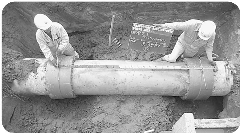
香北土地改良区の用水路復旧工事
