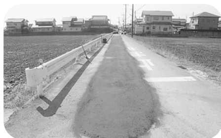
応急復旧された市道1-35号線(野田)
