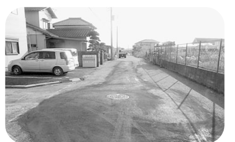
応急復旧された市道4240号線(新開町)
