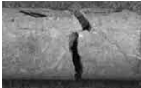
石綿セメント管の亀裂状況
