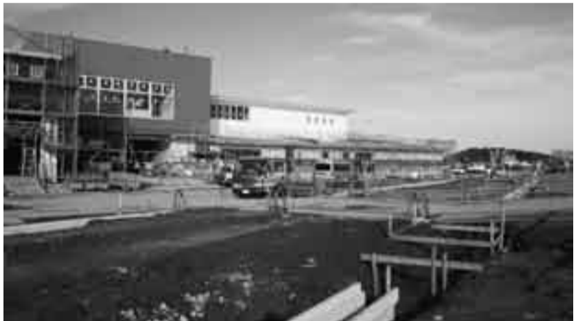
建設中の「水の郷さわら」
