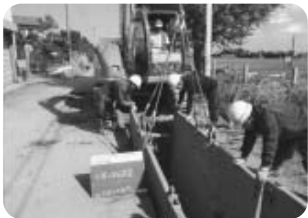
下水道工事 (管布設工事)
