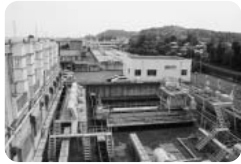
佐原浄化センター（沈砂池機械）
