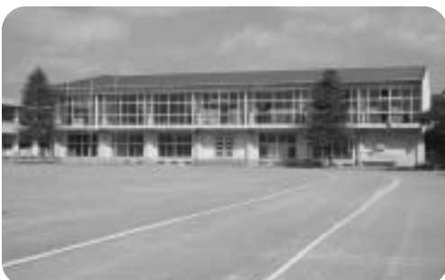
耐震改修を行う小見川中央小学校体育館
