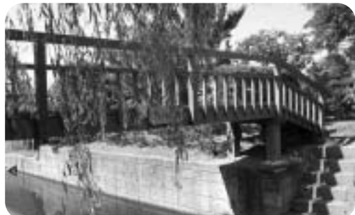
架け替えを行う、加藤洲十二橋(水仙橋)
