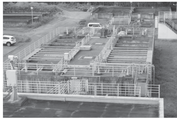
運転監視や維持管理を委託している玉造浄水場
