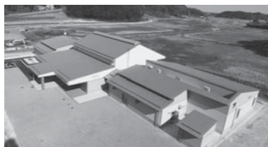
整備中の橋ふれあい公園 (テラス・サンサンと第1工区)
