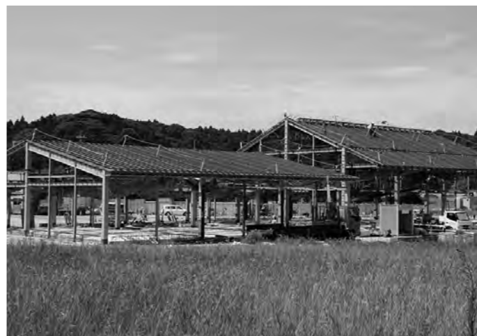
工事が進む橘ふれあい公園内体験学習施設
