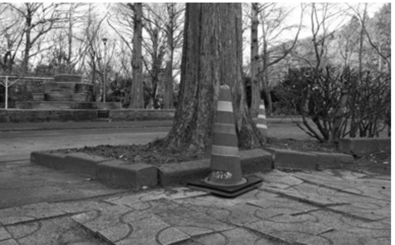
樹木の生長に伴う根上りで破損した小見川城山公園敷設タイル
