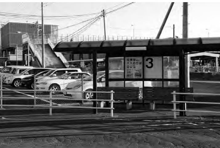
高速バスターミナルの整備が予定されている佐原駅北口
