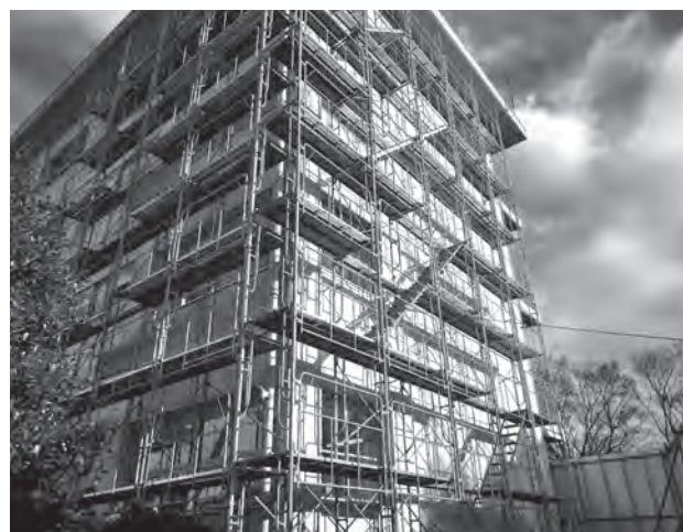
市内の公共工事風景
