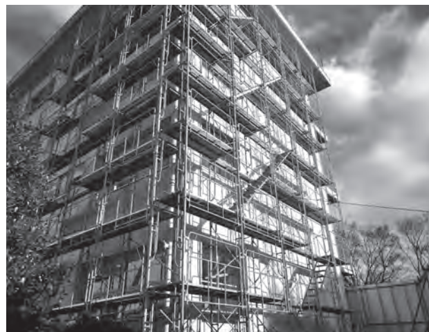
市内の公共工事風景
