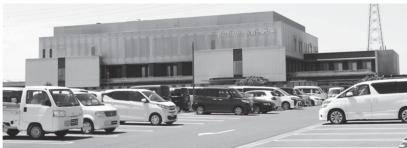
香取おみがわ医療センター駐車場
