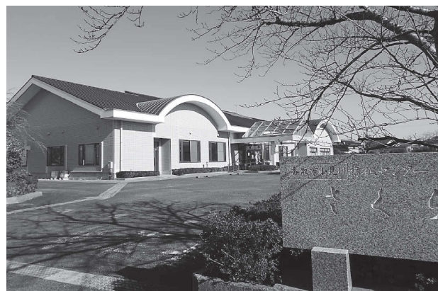
基金を活用して改修した「小見川社会福祉センターさくら館」
