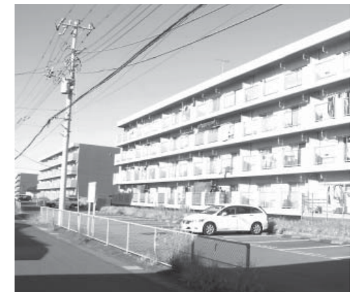
市営住宅粉名口団地
