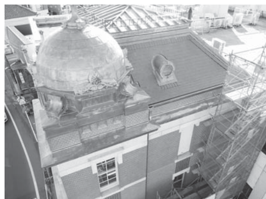
創建当初の状態に保存修理し文化財として復原
