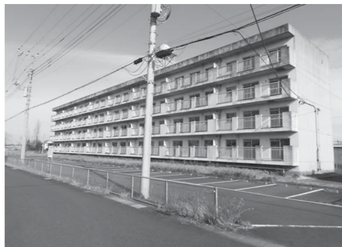
大規模改修工事を実施する市営住宅粉名口団地3号棟
