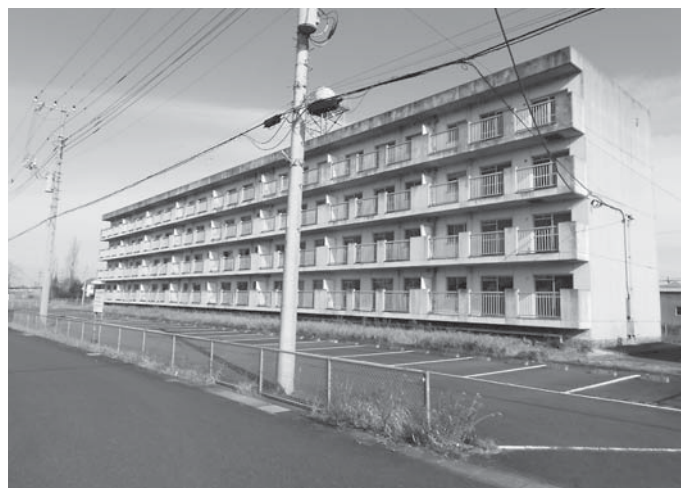
大規模改修工事を実施する市営住宅粉名口団地3号棟
