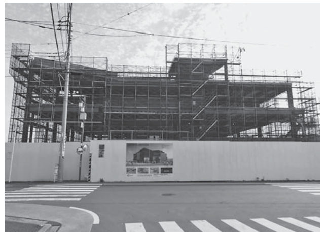
建設中の佐原駅周辺地区複合公共施設
