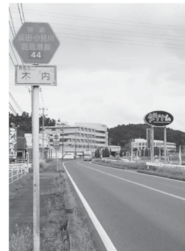
整備された県道成田小見川鹿島港線(木内地先)
