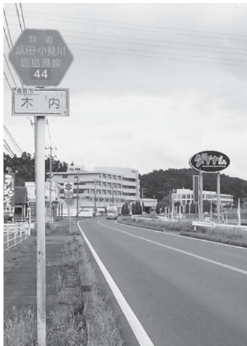
整備された県道成田小見川鹿島港線 (木内地先)
