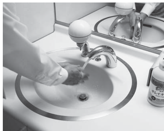
コロナ対策としてトイレ洗面用水栓の自動化を図る
