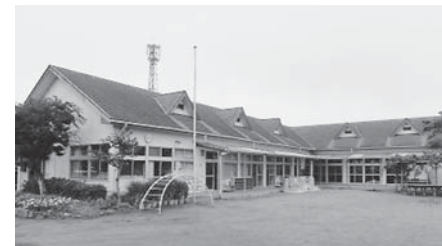
一部改修を行い学童保育として開設予定の津宮幼稚園
