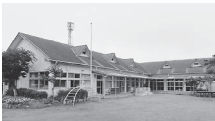
一部改修を行い学童保育として 開設予定の津宮幼稚園
