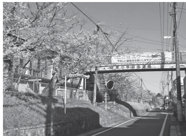
老朽化に伴い撤去となる佐原小学校横断歩道橋
