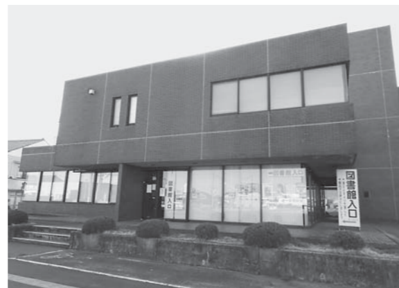
佐原駅周辺地区複合公共施設へ移転する佐原中央図書館
