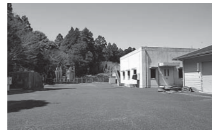
栗源地区大畑浄水場
