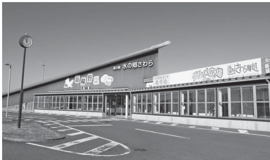
道の駅水の郷さわら
