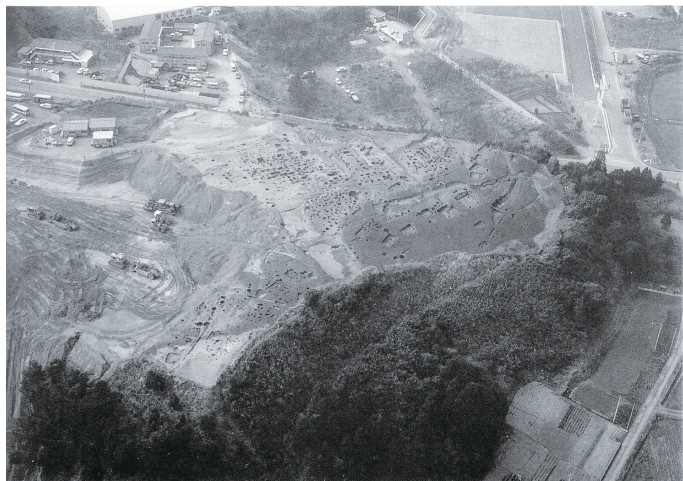
▲調査地空中写真(南東より)
