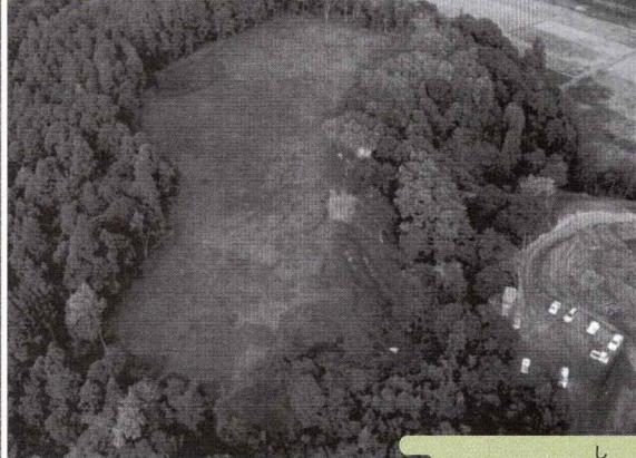
▲遺跡全景空中写真(南側から)
