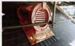
▶天然スレートの屋根と葺き替えられたドーマー
