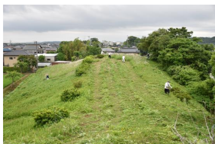
市・大塚山古墳(除草作業)
