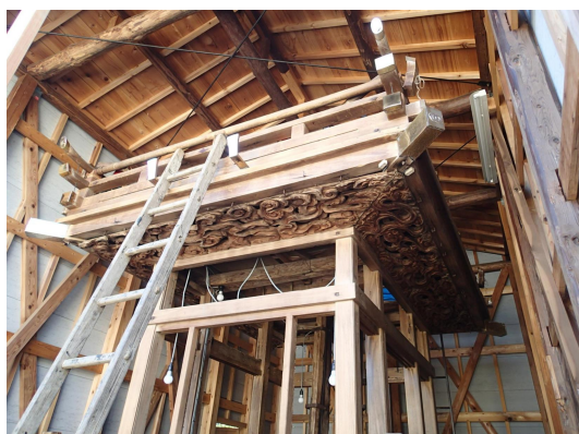
山車実測調査風景
