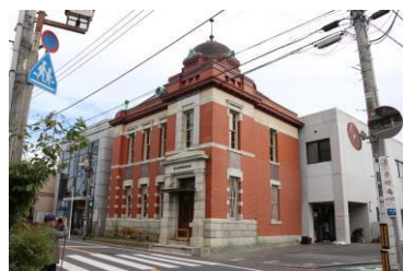
修理中・修理後の様子
