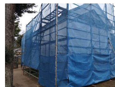
伊能忠敬旧宅土蔵修理状況
