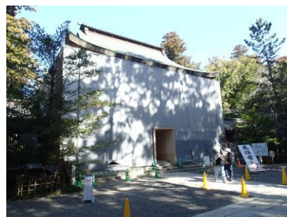
香取神宮楼門修理外観 R6.2.27
