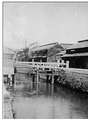
コンクリート製の樋橋 （昭和32年〈1957〉）
