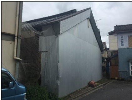
⑦工場（貯蔵庫）
