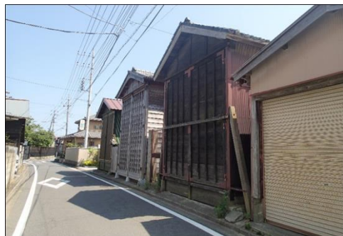
新橋本・下新町・中宿の山車蔵 下新町の山車蔵は旧来の工法で建て替えられた
