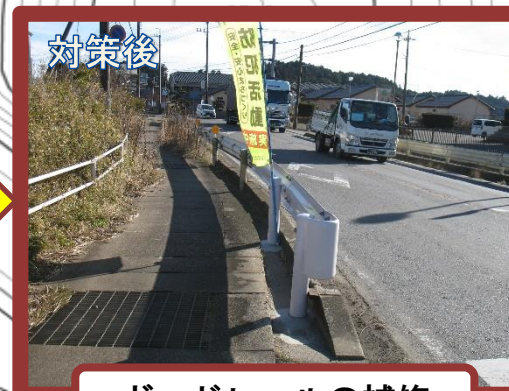
ガードレールの補修
