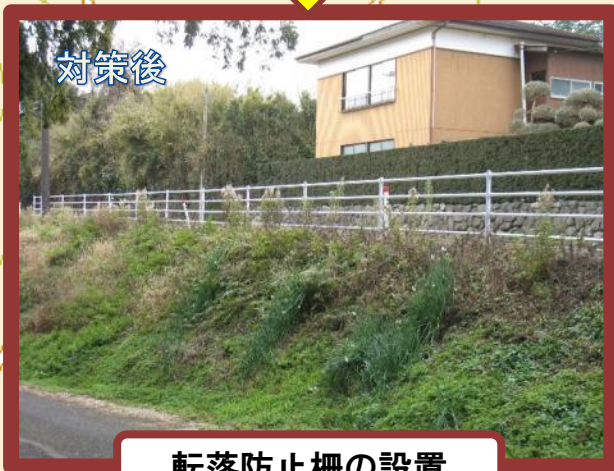
転落防止柵の設置
