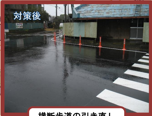
横断歩道の引き直し ポストコーンの設置
