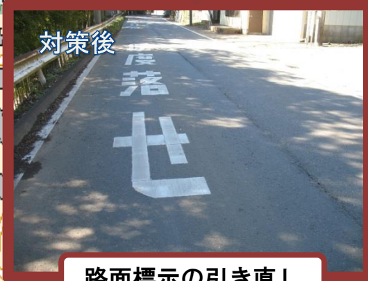
路面標示の引き直し
