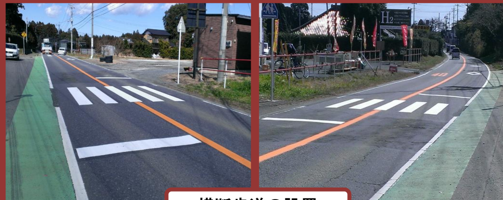
横断歩道の設置
