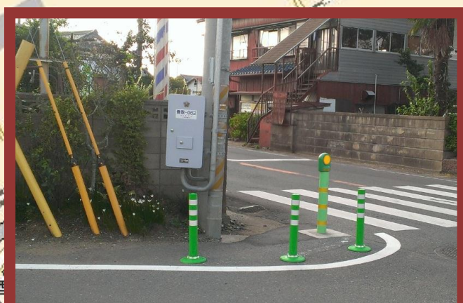
ポストコーンの設置と外側線の引き直し
