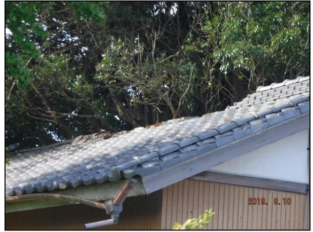
○棟瓦の欠落
