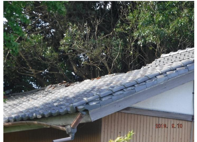
【棟瓦の欠落】
