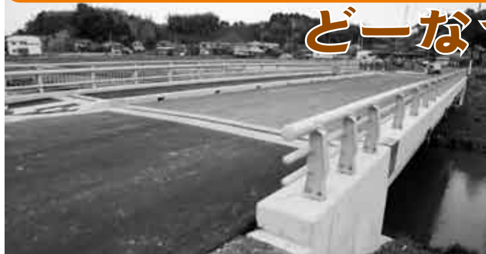
▲平成19年度に工事が完了した新川橋(岩部)
