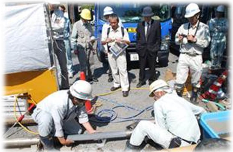
ボーリング調査
