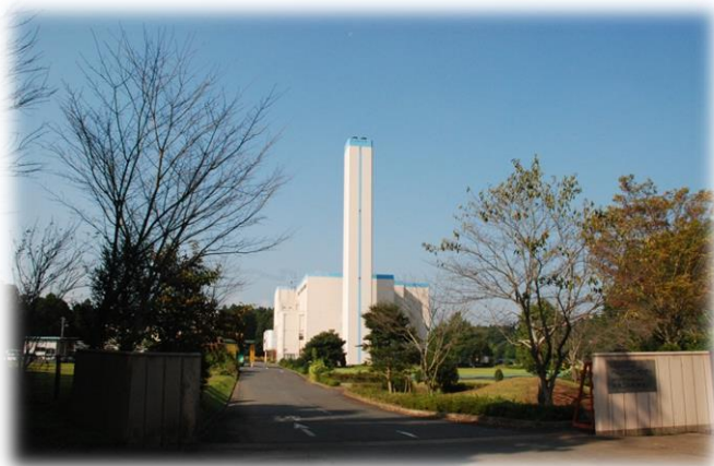
伊地山クリーンセンター
