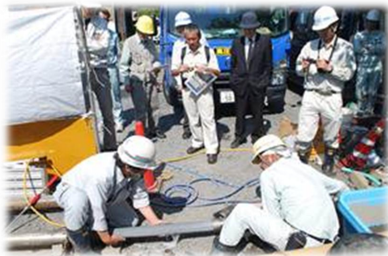
ボーリング調査
