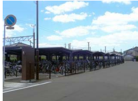
小見川駅自転車駐車場整備事業
