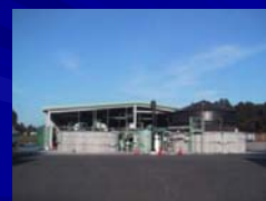
山田バイオマスプラント
