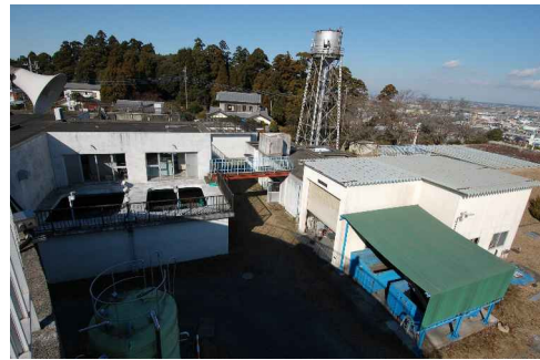
佐原浄水場全景
