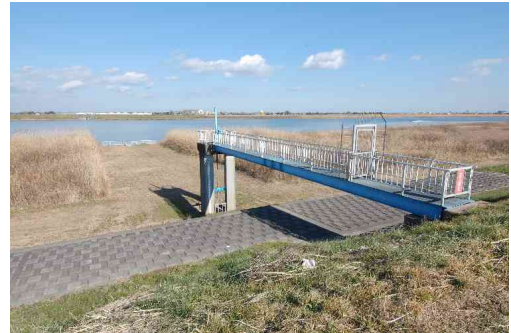
飯島取水場取水口
