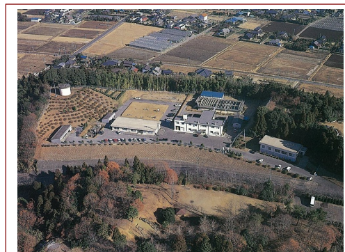
城山第2浄水場全景
