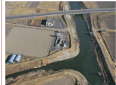
黒部川取水場全景
