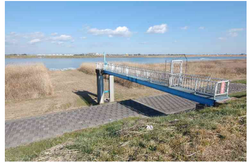
飯島取水場取水口
