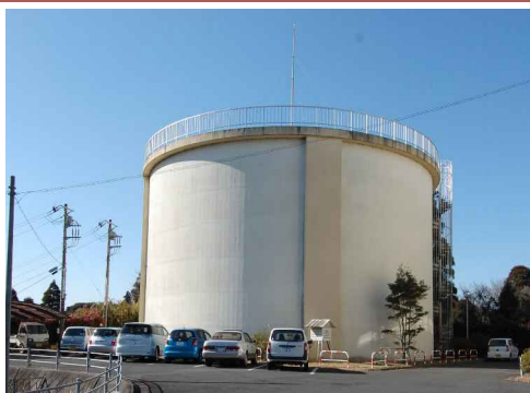
玉造浄水場配水池
