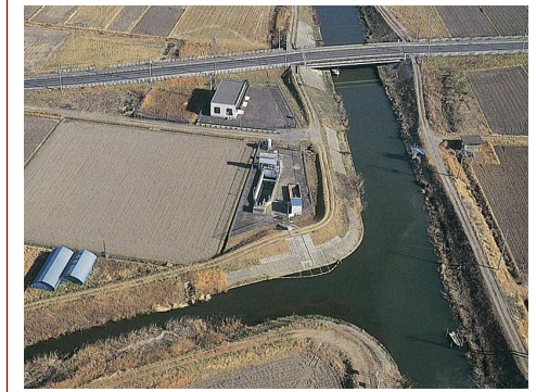
黒部川取水場全景
