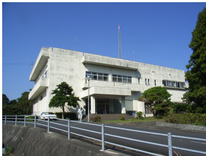
玉造浄水場 管理棟
