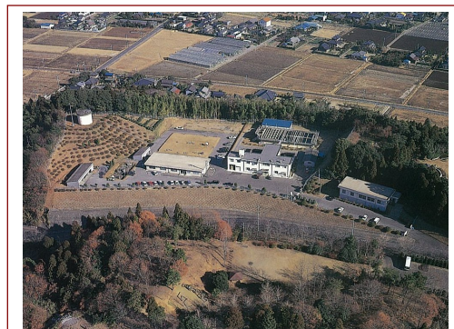
城山第2浄水場全景
