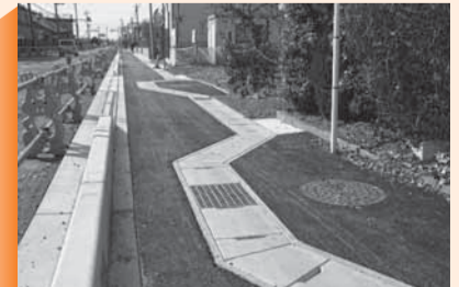
3月末で復旧工事が完了予定
