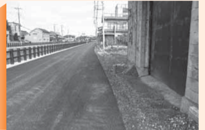
復旧工事が完了
