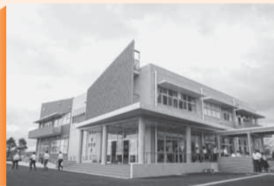
平成25年8月に完成した新校舎
