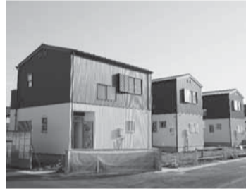
▲4月から入居開始予定の災害公営住宅(岩ヶ崎)
