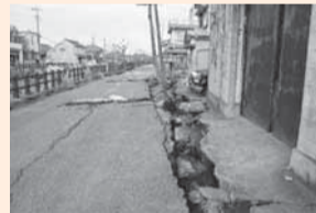
地面に亀裂が入り、電柱が傾く
