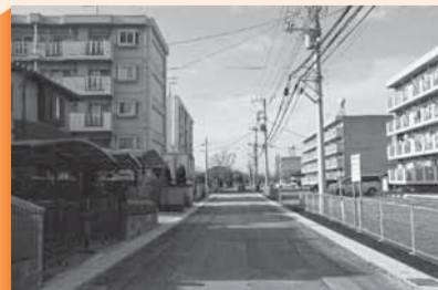
復旧工事が完了
