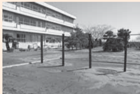
液状化により校舎は傾き半壊に
