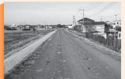
復旧工事が完了し、通行可能に
