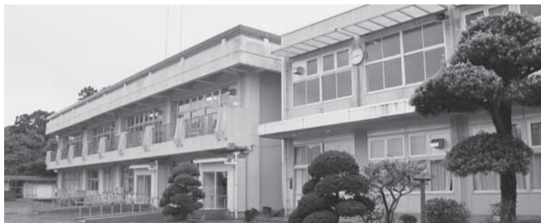
▲地域の障害者福祉施設として生まれ変わった旧高萩小学校の校舎
