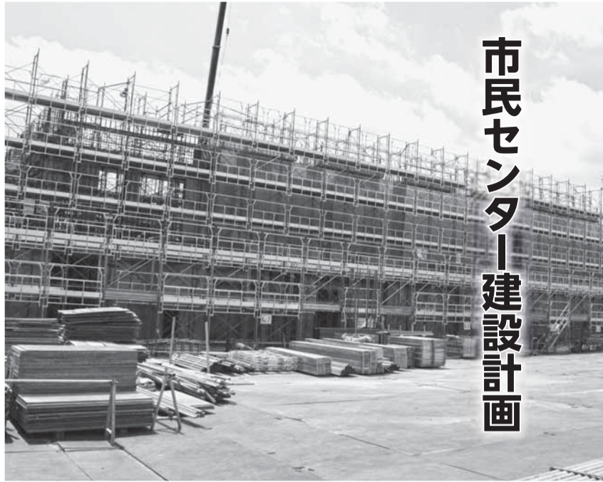
▲現在、オープンに向け工事が進む(仮称)小見川市民センター
