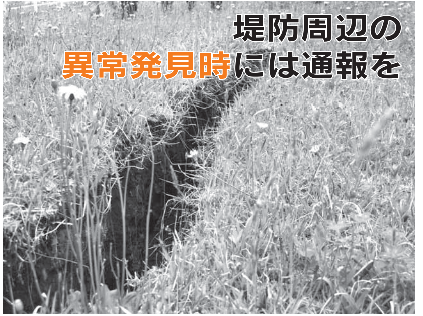
▲各所にひび割れがみられる利根川堤防
