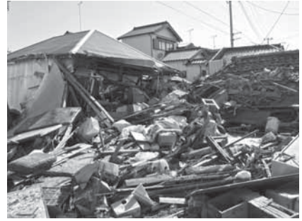
▲津波により倒壊した家屋 (旭市提供)
