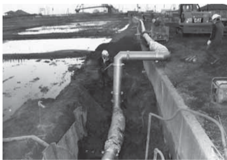
▲約16kmにも及ぶ仮設配管
