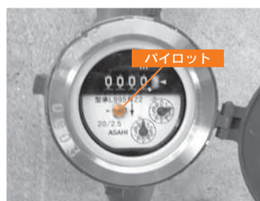
水道メータの蓋を開け、パイロットを確認
